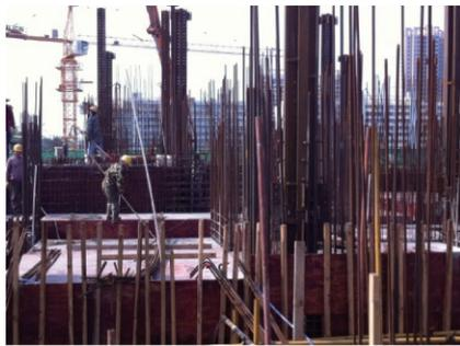
图 16 类似工程增设较多型钢的施工现场
