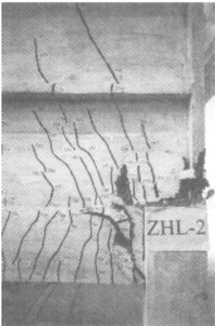
图 14 ZHL-2 右端破坏时裂缝情况及破坏形态
