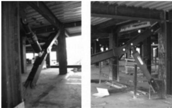
图5 部分国外工程的套索阻尼器
