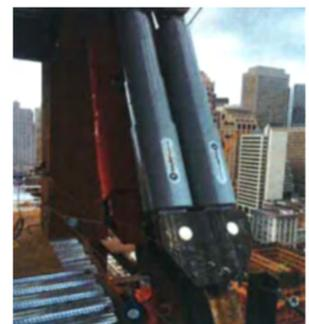
图 4 斜撑式布置的液体黏滞阻尼器
